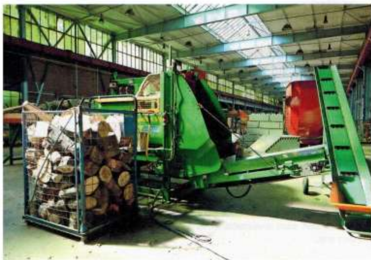
Holzverarbeitung für das Blockheizkraftwerk am Standort.
